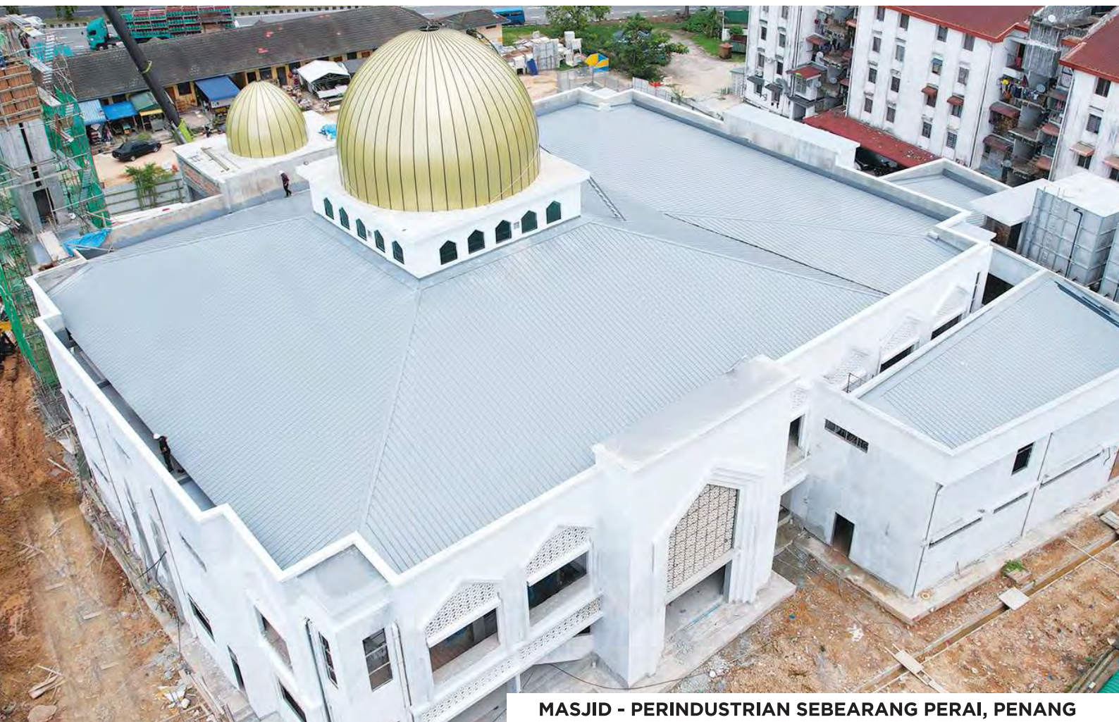
MASJID - SEBEARANG PERAI, PENANG
